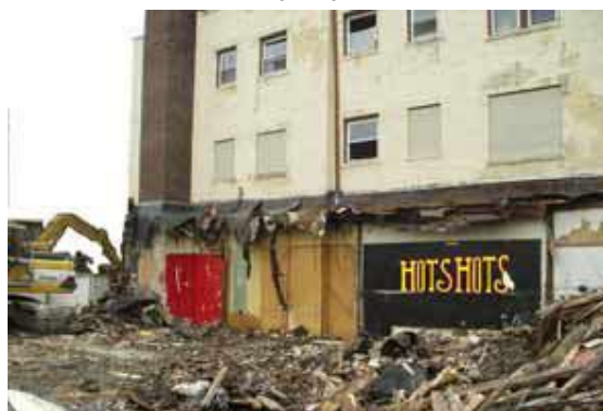
Demolição de um antigo bar e de um hot-spot de tráfico de droga: A remoção de uma instalação de alto risco poderá ser a melhor forma de reduzir o crime.
